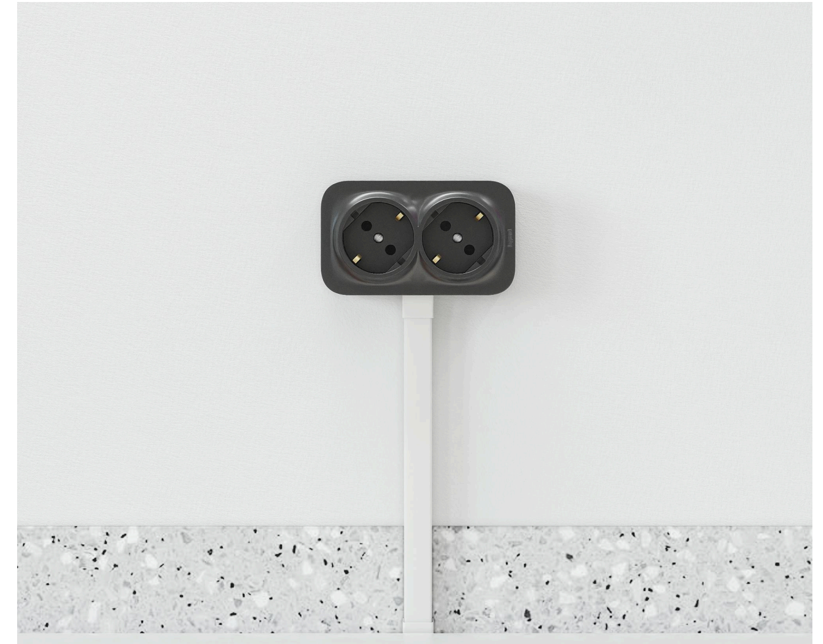
Открытая электрика с пола
